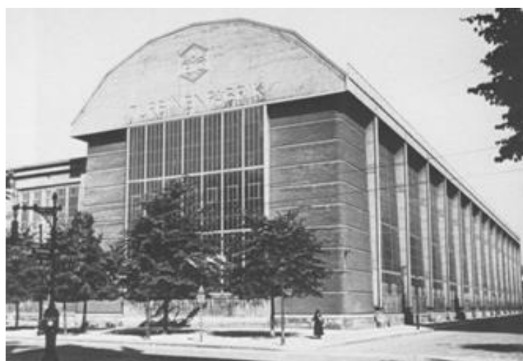
Рисунок 2 – Турбинный завод, построенный для AEG в 1909 г.
